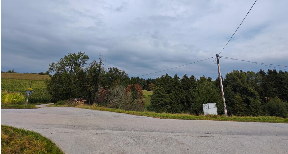
Blick nach Norden Richtung Kalling (nicht sichtbar)
